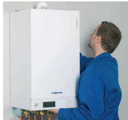
2. Montage de la chaudière
